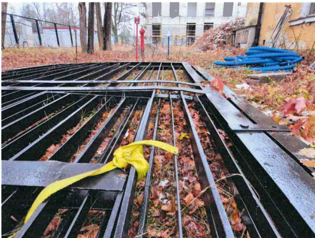
Fot. 9. Deformacje płaszczyzny i geometrii bramy
