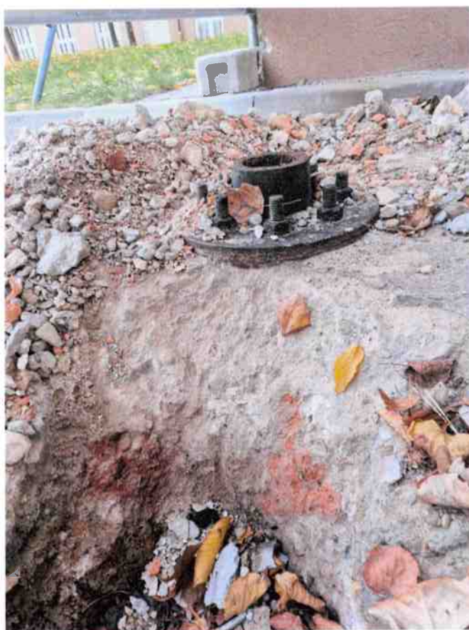
Fot. 4. Gniazdo dolne - uchwyt dolny skrzydła prawego bramy wraz z fragmentem fundamentu
