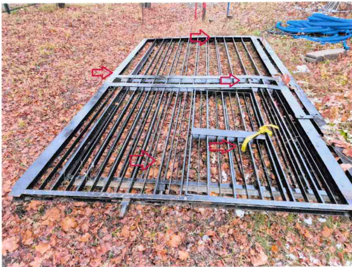
Fot. 7. Oznaczenie wybranych istniejących uszkodzeń zdemontowanych skrzydeł bramy
