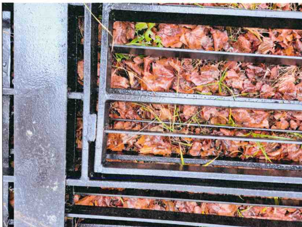
Fot. 10. Sposób mocowania drzwi przejściowych w skrzydle bramy
