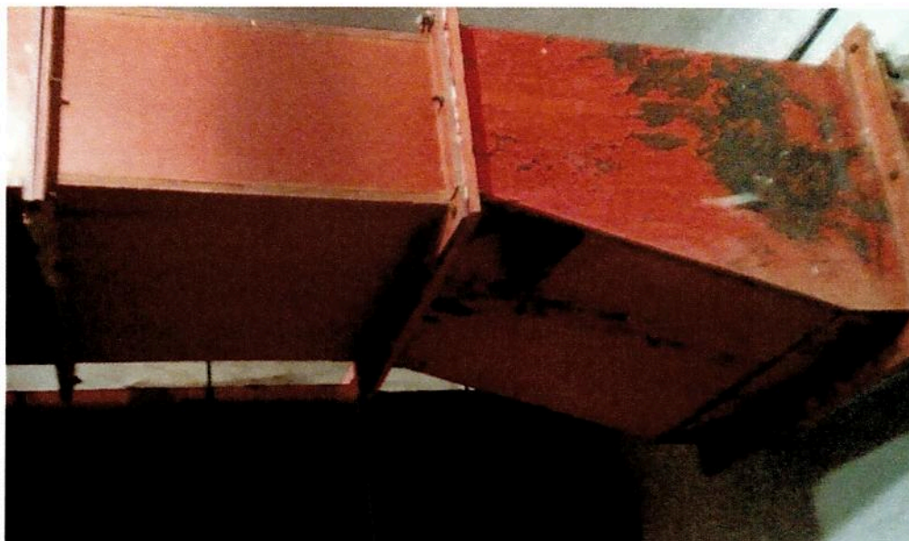
Rys. 1 – Istniejące kanały wentylacyjne
