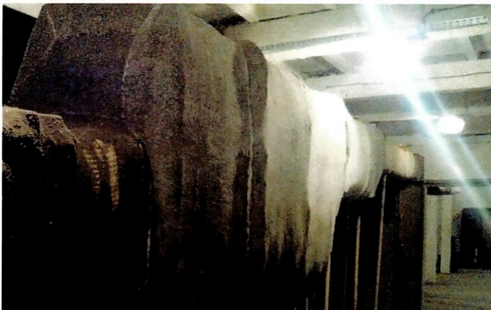
Rys. 2 – Istniejące kanały wentylacyjne
