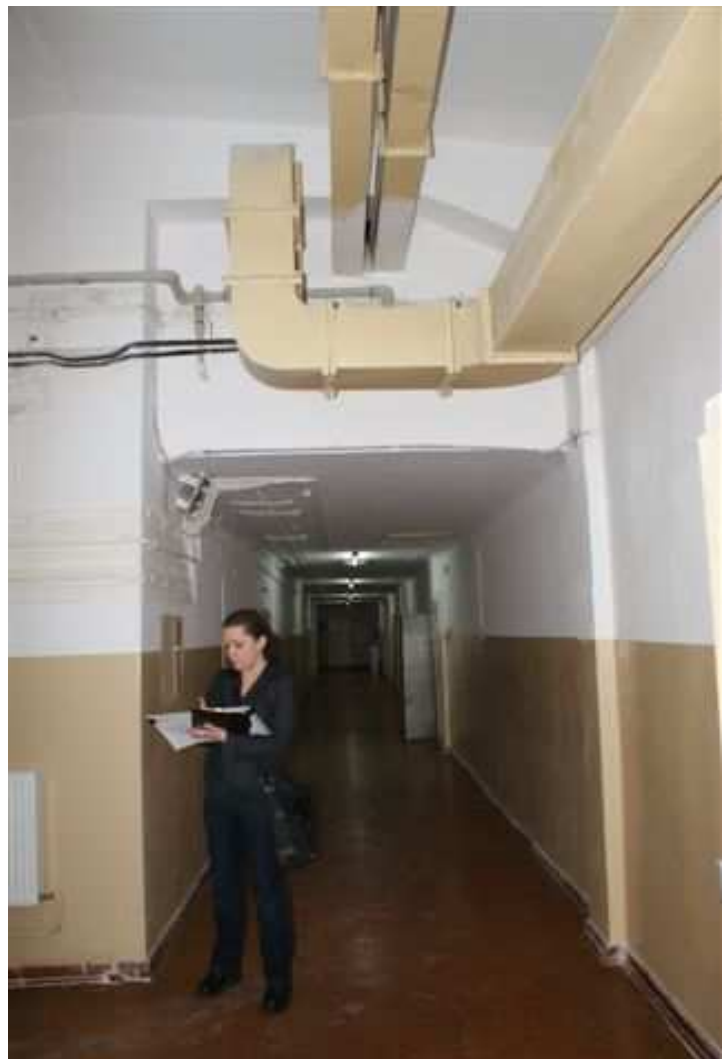
WIDOK NA KORYTARZ nr 3
