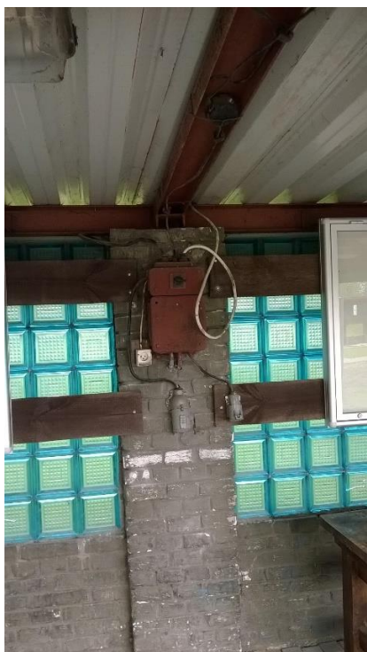
Widok starej instalacji w wiacie.
