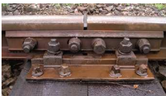
Rys. 1.9 Nieizolowane złącze podparte [16].
