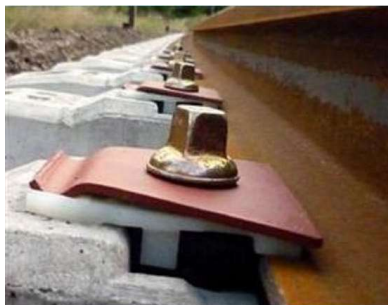
Rys. 1.27 Przytwierdzenie Nabla [75].
