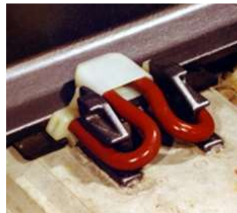
Rys. 1.28 Przytwierdzenie Pandrol Fastclip [40].
