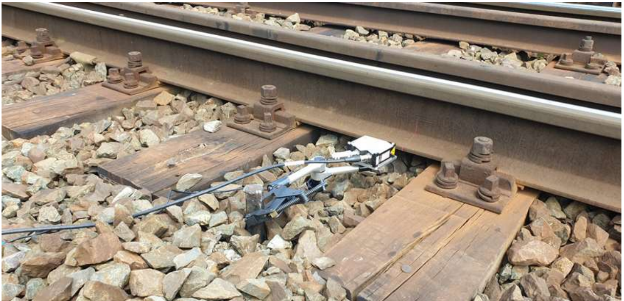
Rys. 4.8 Stanowisko pomiarowe – wiadukt kolejowy w km 88,882 LK nr 272 – fotografia własna.
