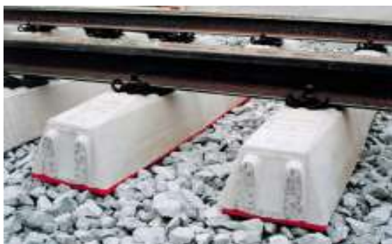
Rys. 1.31 Elastyczne podkłładki pod podkładami strunobetonowymi [25].
