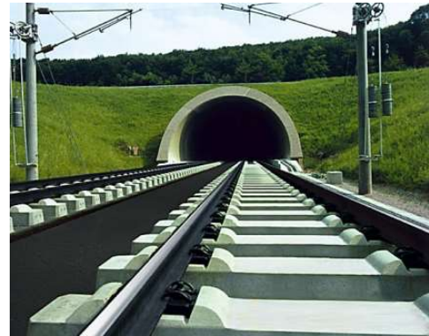
Rys. 1.44 Nawierzchnia typu GETRAC [60].
