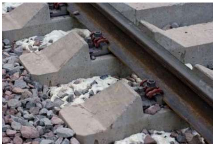
Rys. 1.30 Warstwa tłucznia powierzchniowo stabilizowana pianą poliuretanową w okienkach między podkładami [74].
