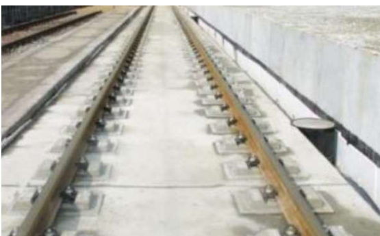
Rys. 1.45 Nawierzchnia typu EBS [86].
