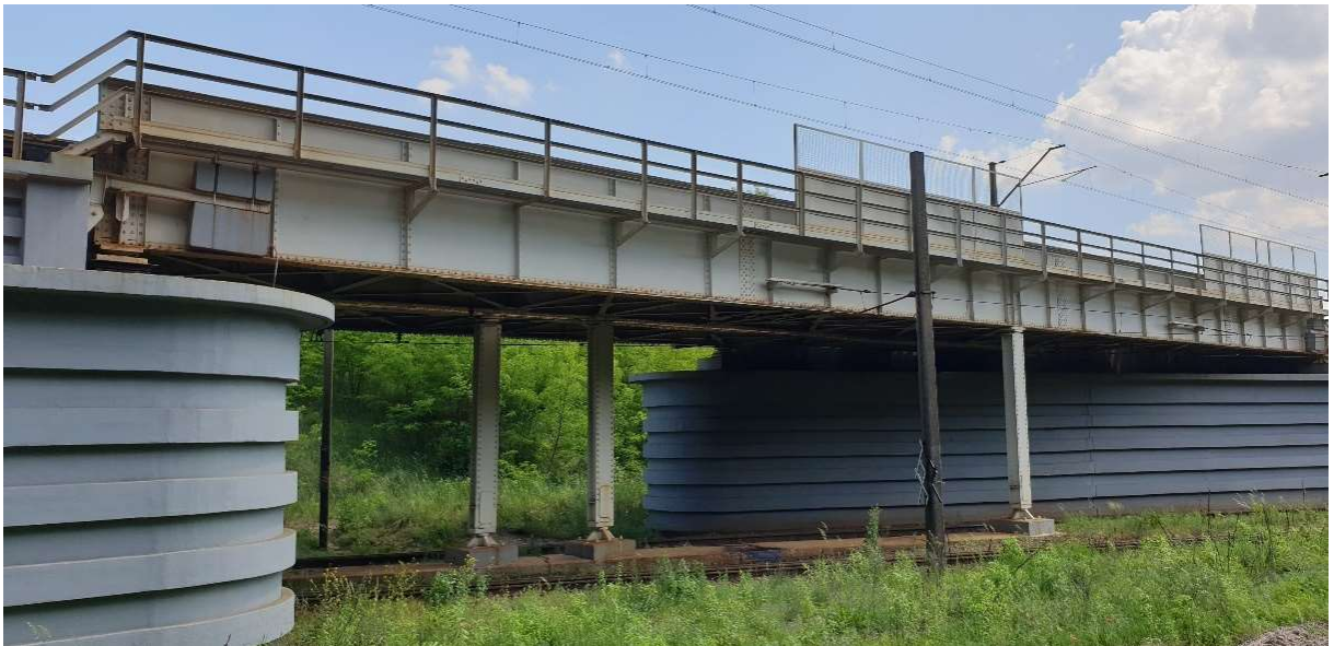
Rys. 4.20 Wiadukt kolejowy w km 88,882 LK nr 272 – fotografia własna.
