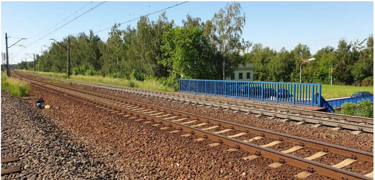
Rys. 4.13 Nawierzchnia na wiadukcie kolejowym w km 83,808 LK nr 272 – fotografia własna.
