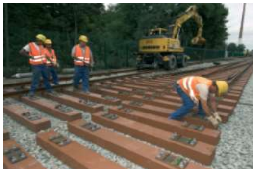
Rys. 1.22 Układanie podkładów polimerowych [87].
