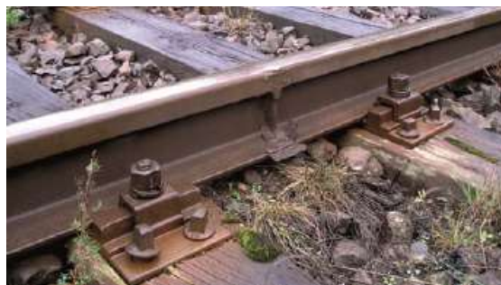
Rys. 1.12 Złącze spawane [16].
