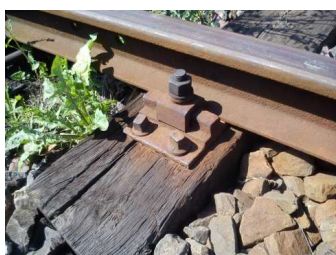
Rys. 1.23 Przytwierdzenie typu K – fot. własna.
