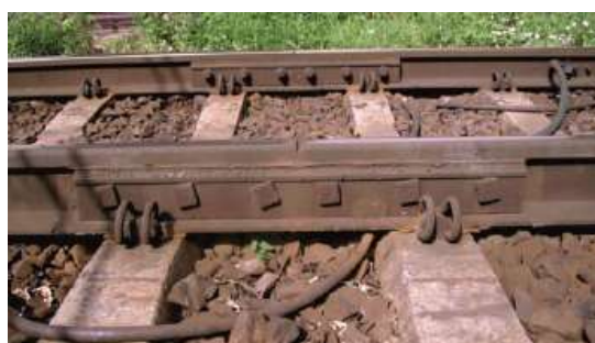
Rys. 1.10 Izolowane złącze wiszące klejono-sprężone [16].
