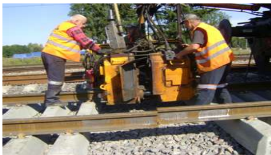
Rys. 1.11 Zgrzewanie szyn łukiem elektrycznym – fotografia własna.
