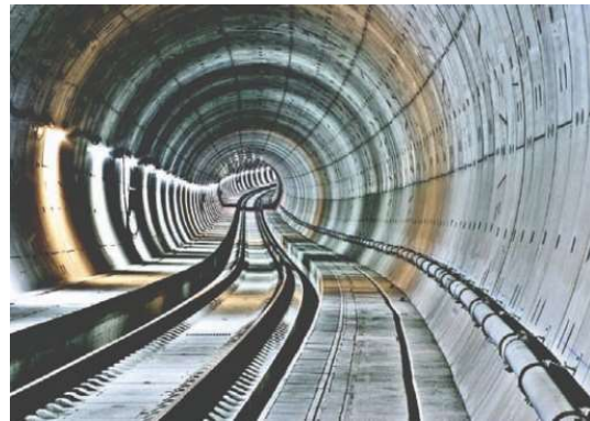
Rys. 1.42 Nawierzchnia typu OBB – PORR w tunelu [16].
