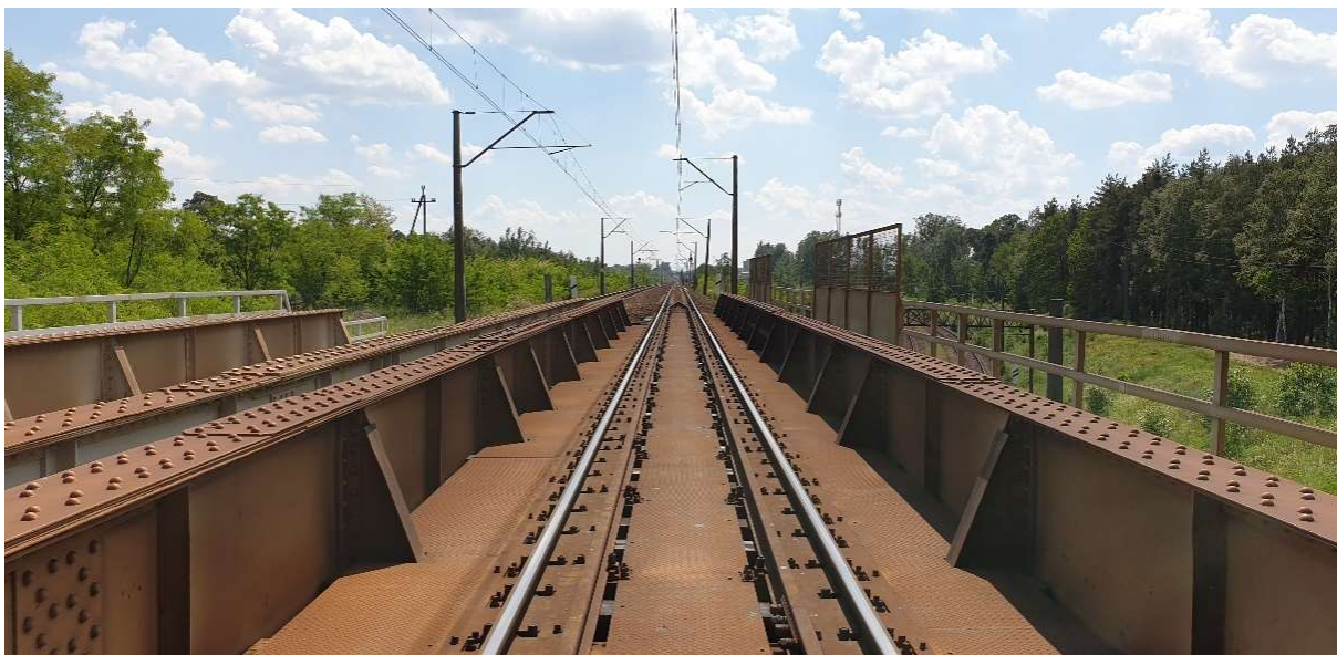
Rys. 4.18 Nawierzchnia bezpodsypkowa na wiadukcie kolejowym w km 83,808 LK nr 272 – fotografia własna.
