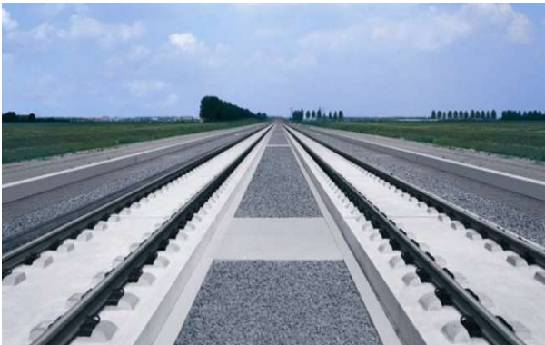
Rys. 1.43 Nawierzchnia typu RHEDA 2000 [32].
