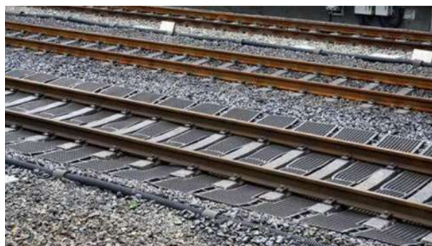
Rys. 1.32 Maty stabilizujące położenie ziaren kruszywa na linii dużych prędkości w Japonii [74].
