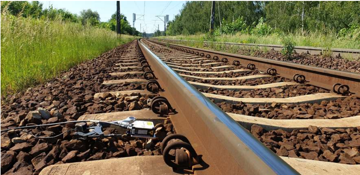
Rys. 4.6 Stanowisko pomiarowe – wiadukt kolejowy – km 83,808 LK nr 272 – fotografia własna.
