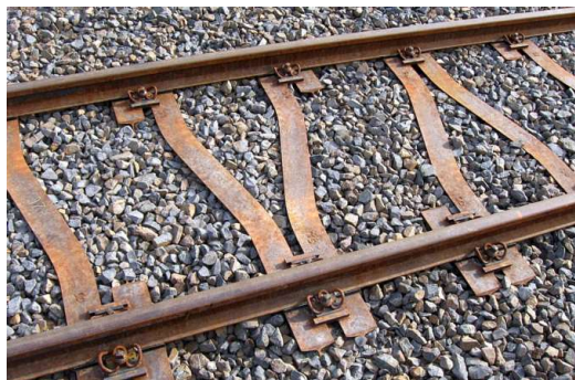
Rys. 1.21 Stalowe podkłady typu Ypsilon [83].
