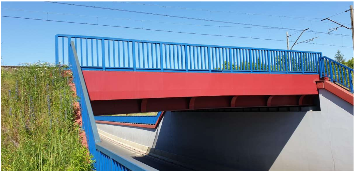
Rys. 4.14 Wiaduk kolejowy w km 83,808 LK nr 272 – fotografia własna..
