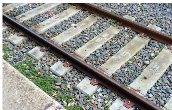
Rys. 1.15 Tor na betonowych podkładach monoblokowych z przytwierdzeniami typu Nabla – fotografia własna.
