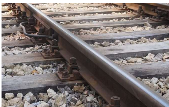
Rys. 1.14 Tor na drewnianych podkładach z przytwierdzeniami typu K [82].
