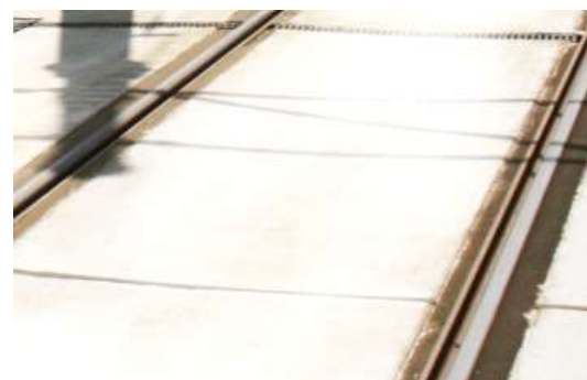
Rys. 1.46 Nawierzchnia typu ERS [33].
