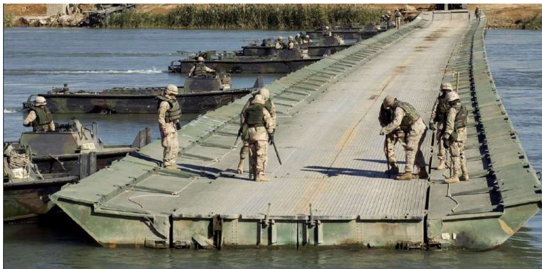
Rys. 1.9. Most pontonowy IRB w czasie budowy przeprawy [13]
