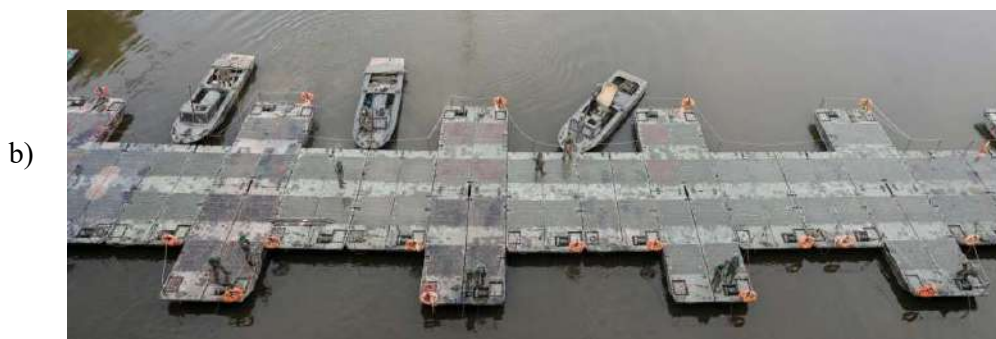
Rys. 1.7. Mosty zbudowane z wykorzystaniem PP-64: a) konfiguracja wstęgi mieszanej typu C [9], b) konfiguracja wstęgi podwójnej [10]
