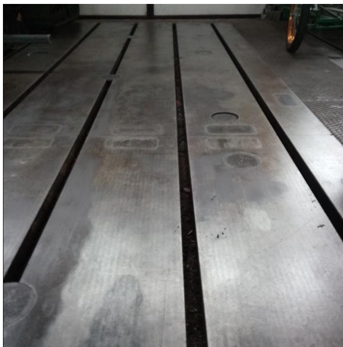
Rys. 7.18. Fragment stalowej podłogi jako odcinek badawczy
