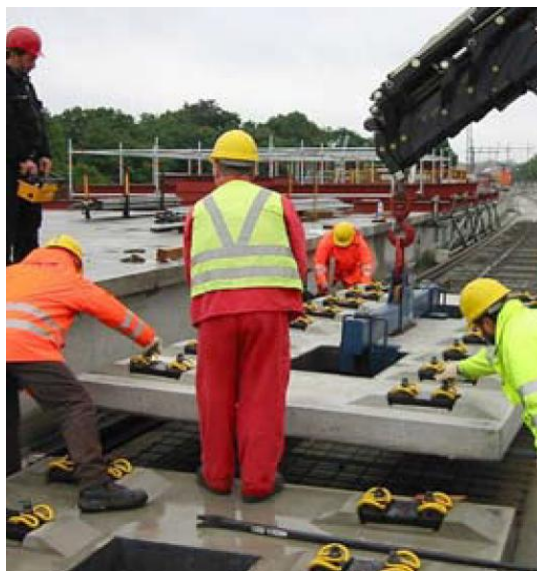
Fot. 1.5. Płyty ÖBB-PORR podczas montażu [29]
