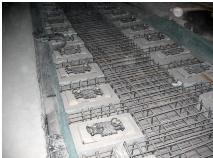
Fot. 1.7. Podpory blokowe przed zabetonowaniem [70]
