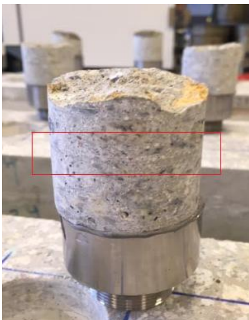
Fot. 5.3. Próbką po przeprowadzeniu badania z miejscem połączenia betonów (fot. własna)
